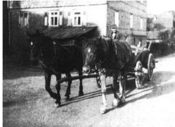
Sejbe Haus, Anfang der 1950er Jahre. Das heutige Gebäude wurde 1792 an Stelle eines älteren errichtet, das sich bereits in Besitz der Familie Seipp befand. Bis 1958 befand sich an der Giebelseite des Hauses die gemeindeeigene Viehwaage, die von der Familie Seipp als Wiegemeister bedient wurde.
